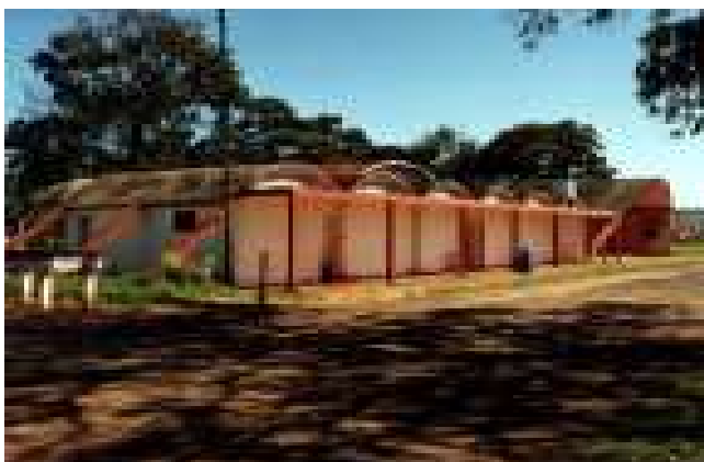
Fig. 49- Edifício dos vestiários e bar do tênis. Executado conforme o projeto original possui grande valor arquitetônico, porém se encontra em lamentável estado de conservação. Fonte: Arquivo pessoal da pesquisadora - 2003
