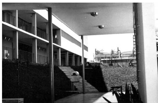
Fig. 43 - Vista da nova passagem coberta. Observar ao fundo outro edifício em construção na década de 60, ao longo da rua Manuel Bento Cruz . Fonte: Arquivo SENAI de Bauru.
