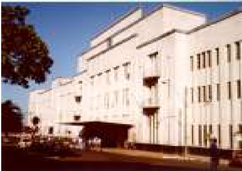
Fig. 93 - Fachada da Sede da Estação Ferroviária conservada até os dias de hoje. Foto de 2001. Fonte: Arquivo pessoal da pesquisadora
