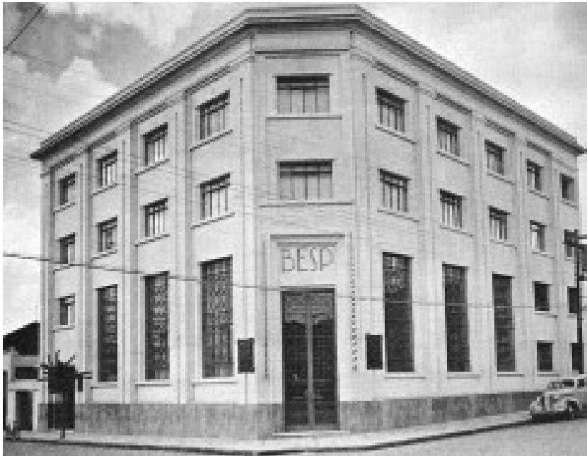
Fig. 103- Banco do Estado de São Paulo na década de 40. Arquitetura ainda hoje presente no centro da cidade.
