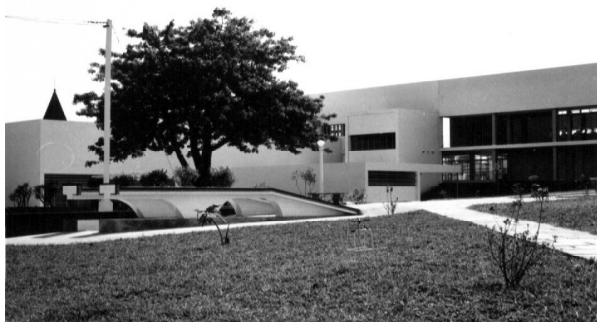
Fig. 42 - Na década de 60 o projeto original foi ampliado. Construiu-se um novo edifício que abrigava os sanitários e uma passagem coberta interligada com a fachada oeste (comparar com a figura 23). Fonte: Arquivo SENAI de Bauru.
