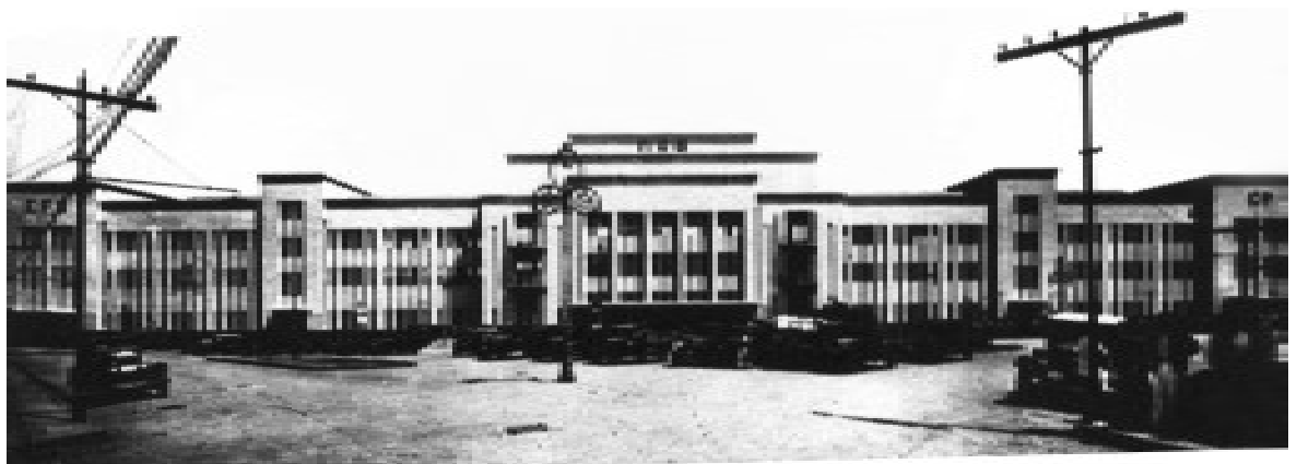
Fig. 88- Foto da fachada logo após o término das obras. Observar que houve algumas modificações em relação ao projeto acima. Início da década de 40. Fonte: Museu Ferroviário Regional de Bauru
