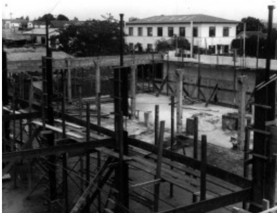
Fig. 26 - Oficina em construção no nível mais baixo do terreno. Observar ao fundo o Pavilhão Social.
