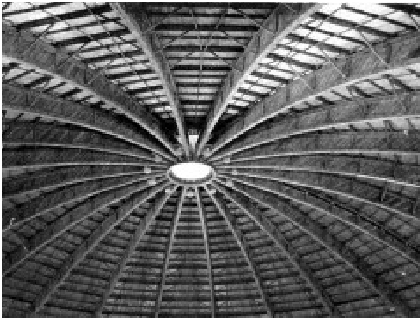
Fig. 35- Cobertura estruturada com arcos de madeira contraplacada.
