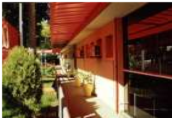
Fig. 49 - Fachada principal. Passarelas cobertas foram distribuídas em diferentes acessos da escola, descaracterizando a arquitetura do edifício.
