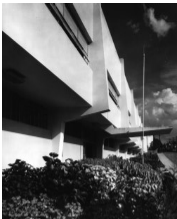
Fig. 19 - Marquise na fachada oeste. Um dos elementos que sugere leveza ao edifício e marca a entrada do SESC.
