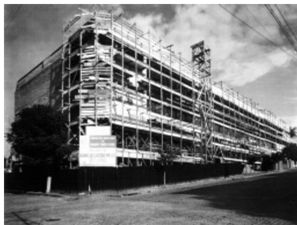
Fig. 82- Etapa mais avançada da obra. Edifício Sede já estruturada e com andaimes até o último pavimento. Década de 50. Fonte: Acervo do arquiteto
