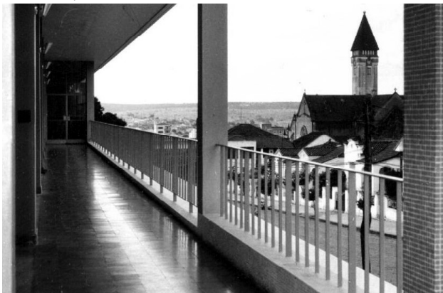
Fig. 38 - Vista da cidade obtida pelo corredor lateral leste do pavimento superior. Fonte: Arquivo SENAI Bauru.
