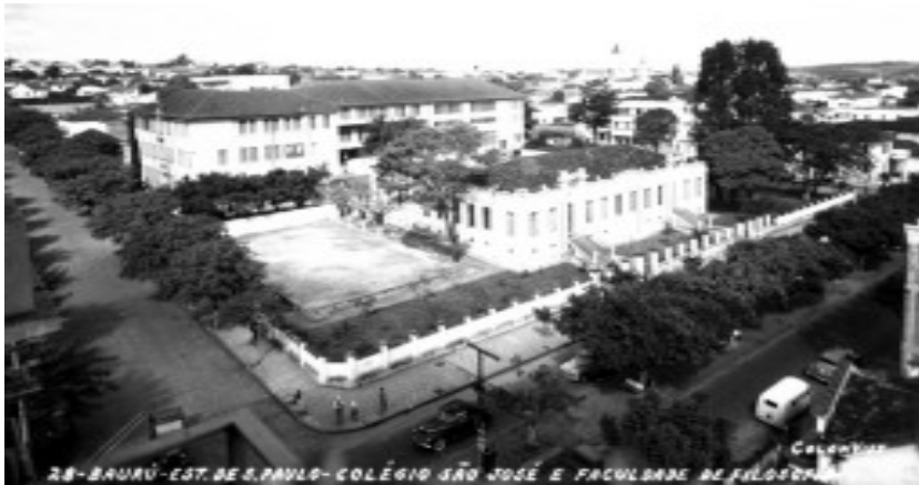
Fig. 70- Vista de toda a quadra que hoje é propriedade do Colégio São José, inclusive o edifício do antigo Colégio Rodrigues de Abreu. Fonte: IHAET
