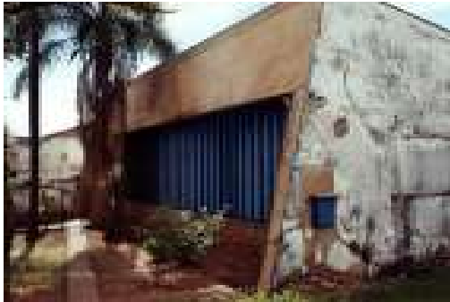
Fig. 62- Fachada principal, observar os brises verticais voltados para a face oeste e o revestimento em pastilhas cerâmicas. Fonte: Arquivo pessoal da pesquisadora - 2003
