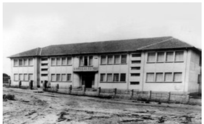
Fig. 71- Ginásio do Estado Ernesto Monte, sede inaugurada em 1939 localizada na Praça das Cerejeiras . Este edifício ainda hoje mantém suas características originais de tendência racionalista. Fonte: IHAET
