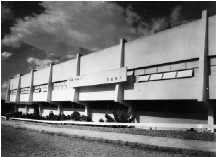
Fig. 15 - Observar a sombra causada pelo recuo do pavimento térreo em relação ao pavimento superior, a qual protege termicamente as janelas do pavimento térreo, tanto da fachada oeste (como mostra a foto) como da fachada leste. Fonte: Arquivo FAU Santos.
