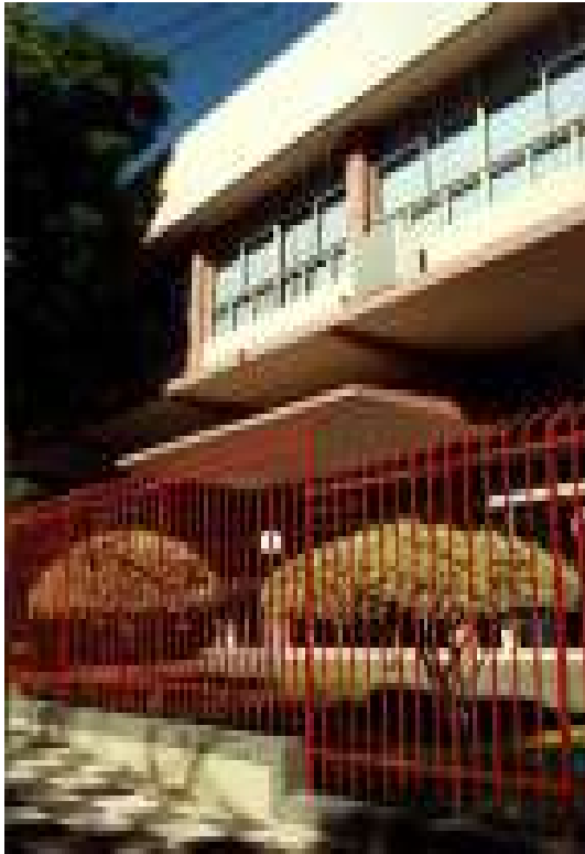
Fig. 44 - Fachada principal. Observar o fechamento do antigo corredor lateral externo do pavimento superior (comparar com a figura 37). Fonte: Arquivo pessoal da pesquisadora - 2003.
