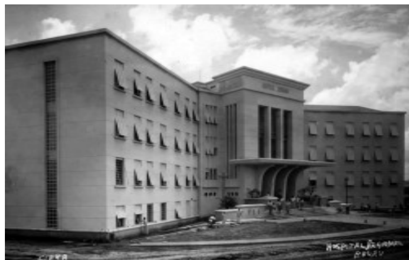
Fig. 102- Hospital Regional Fernando Costa, antiga Santa Casa e hoje Hospital de Base. Inaugurado em 1951, o edifício de tendência racionalista é marcado pela funcionalidade na divisão de suas alas. Fonte: IHAET
