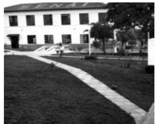
Fig. 39 - Vista do pátio interno obtida pelo corredor lateral oeste do pavimento superior. Fonte: Arquivo SENAI Bauru.
