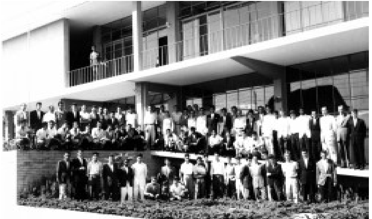
Fig. 37 - Observar o corredor leste do pavimento superior. Esta circulação além de tornar a escola aberta para a cidade, também proporcionou proteção térmica nas paredes envidraçadas das salas de aula. Foto de 1960. Fonte: Arquivo SENAI Bauru.
