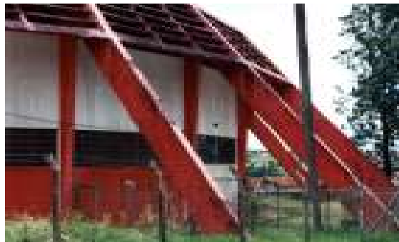
Fig. 51- Ginásio de Esportes, observar o dinamismo estrutural característico nas obras de Castro Mello. Fonte: Arquivo pessoal da pesquisadora - 2001
