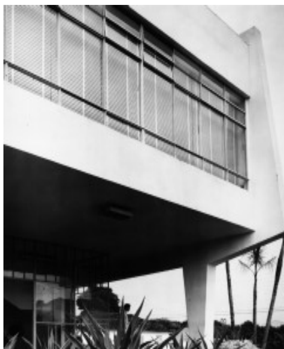
Fig. 18 - Vista lateral de um dos pórticos laterais que fazem parte da estrutura do edifício. Observar parte da fachada leste e entrada do SENAC.
