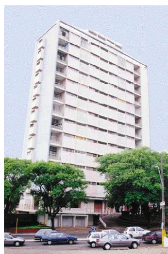
Fig. 20- Vista atual do edifício que mantém suas características originais. Fonte: Arquivo pessoal da pesquisadora-2001
