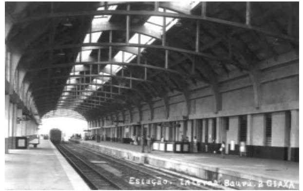
Fig. 92 - Vista interna da estação, soluções geométricas simples resultando numa grande riqueza formal. Década de 40. Fonte: Museu Ferroviário Regional de Bauru
