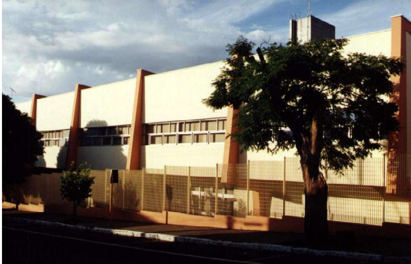
Fig. 25- Vista da fachada oeste, observar as janelas originais ainda existentes. Fonte: Arquivo pessoal da pesquisadora -2003
