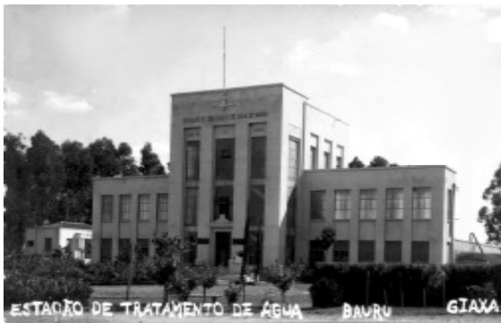
Fig. 100- Estação de Tratamento de Água, prédio inaugurado em 1942 numa arquitetura racionalista. Fonte: IHAET
