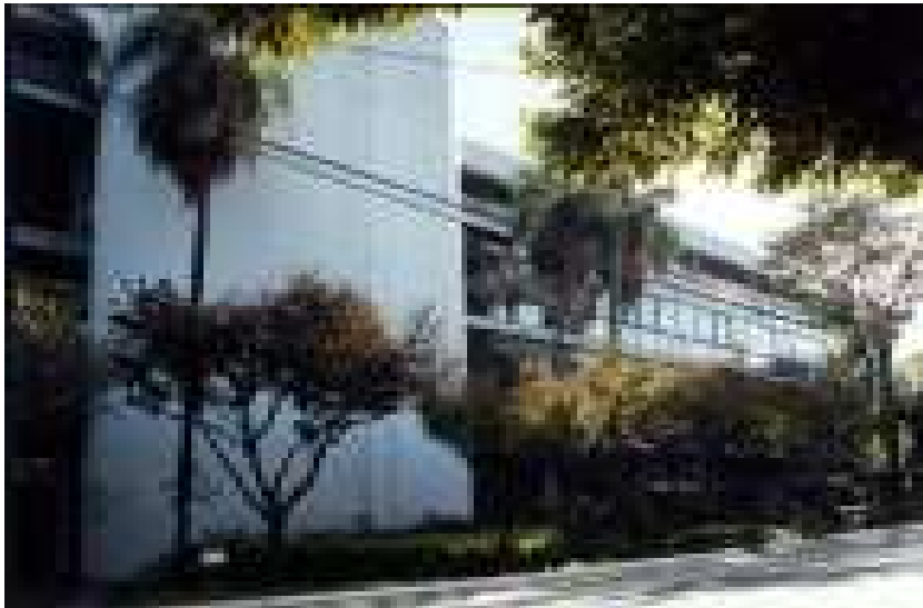
Fig. 46 - Vista da fachada sul voltada para rua Padre João . Em primeiro plano o volume da caixa de escada do hall dos funcionários.
