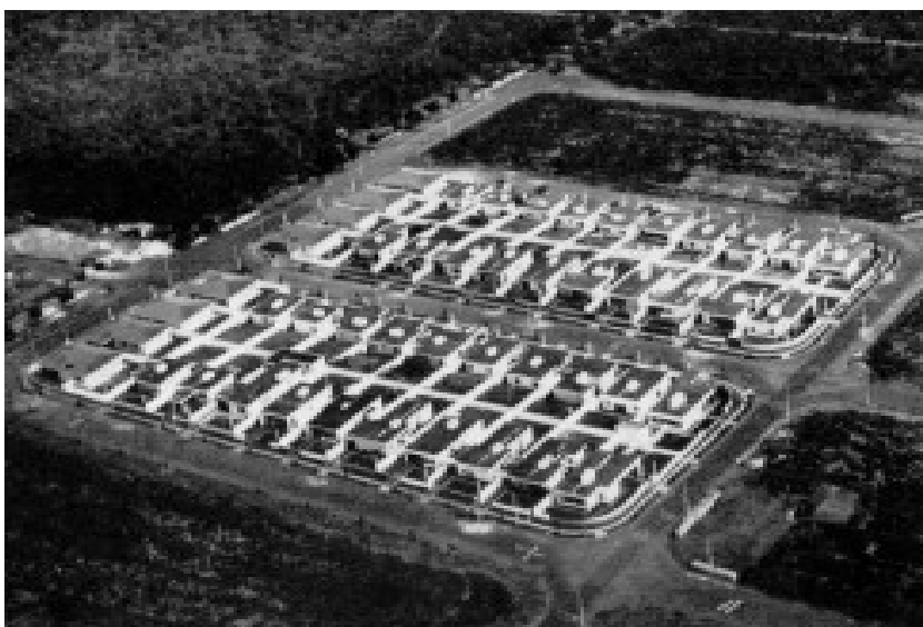
Fig. 2- Foto aérea do loteamento. Década de 60. Fonte: Acrópole 289 (1962, p.20)
