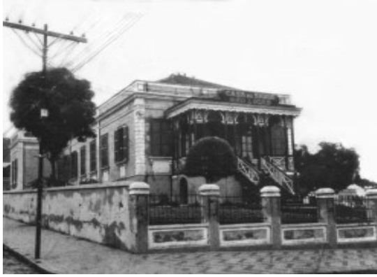
Fig. 74- Casa de Saúde São Lucas, inaugurada em 1932 no cruzamento da rua Gerson França com a avenida Rodrigues Alves . O alpendre fronteiro foi justaposto à edificação, rompendo com o ecletismo sóbrio e proporcionando ares de bangalô. Fonte: IHAET
