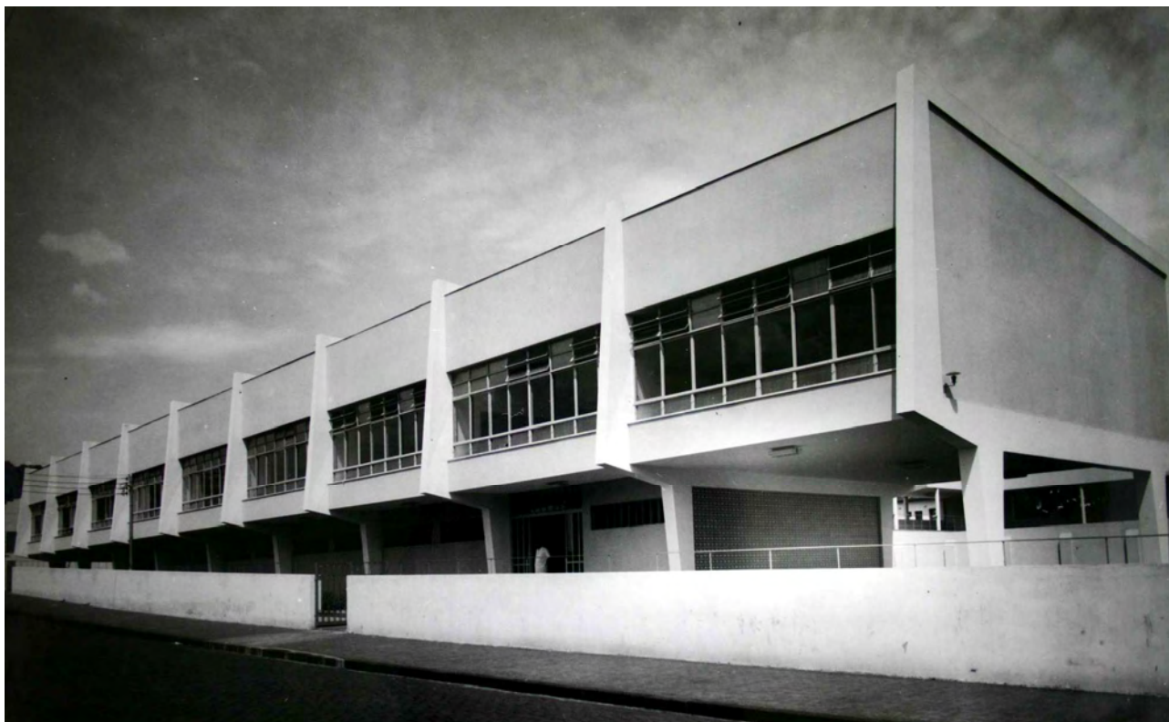
Figura 28: Vista da fachada sudeste do bloco da escola, Escola Sesc-Senac de Ribeirão Preto. Observar o acesso do SESC pela rua Tibiriçá. Fonte: Foto Moscardi, arquivo FAUS
