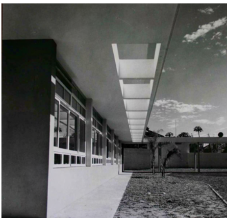
Figura 25: Laje vazada e em balanço, bloco SENAC, face nordeste. Observar o sombreamento proporcionado nas janelas das salas de aula e laboratório. Fonte: Foto Moscardi, arquivo FAUS
