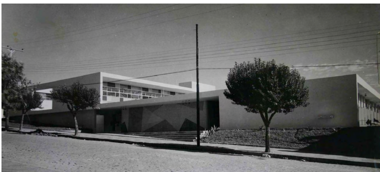
Figuras 15, 16 e 17: Perspectiva, maquete e foto da Escola Sesc-Senac de Marília. Observar as semelhanças e as diferenças entre as etapas de projeto e o edifício construído. Fonte: Foto Moscardi, arquivo FAUS
