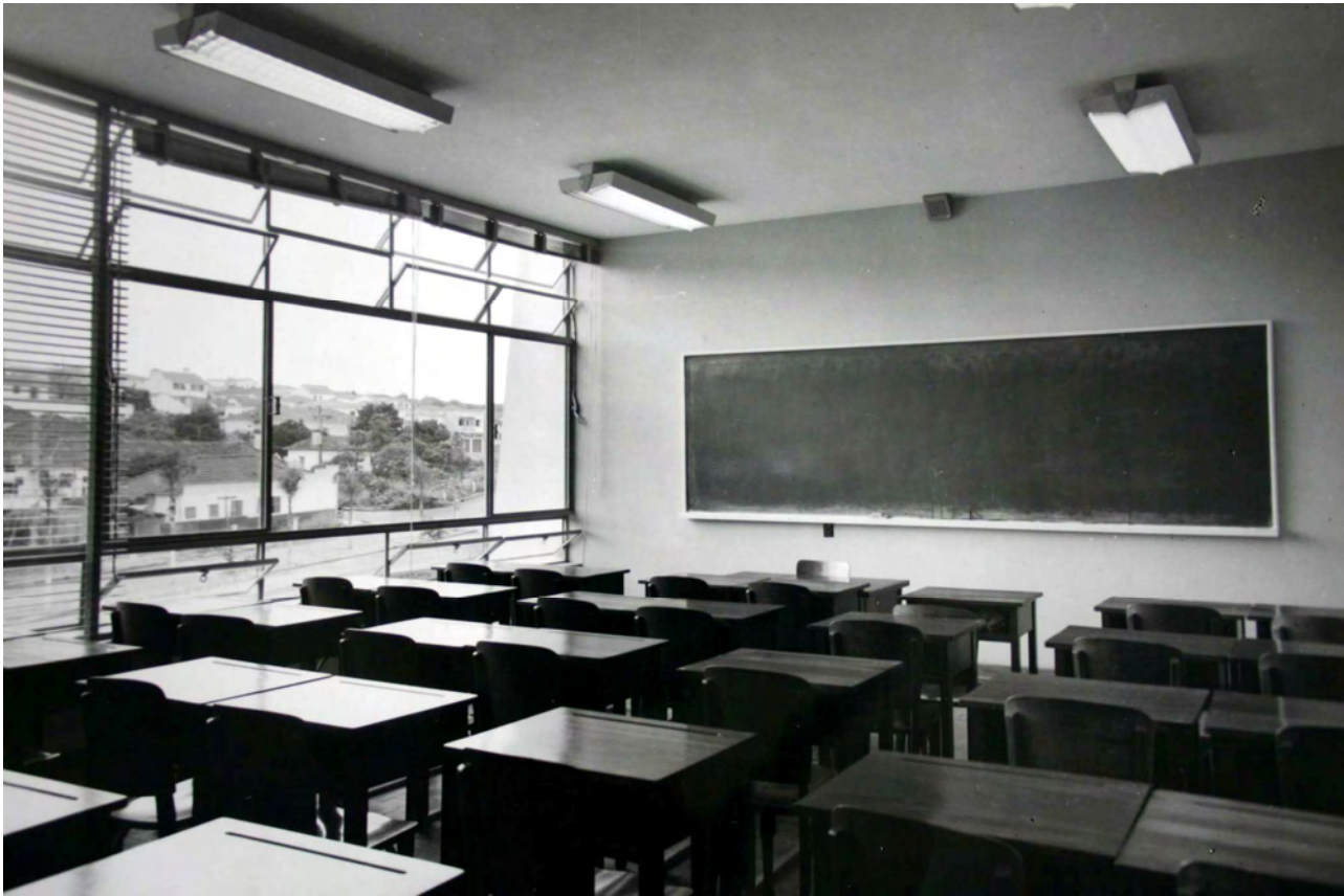
Figura 18: Salas de aula do SENAC, janelas à esquerda dos alunos, favorecendo a iluminação natural da face leste. Fonte: Foto Moscardi, arquivo FAUS
