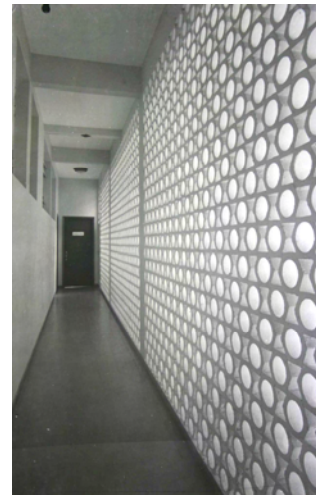
Figura 22: Circulação lateral de serviço, face nordeste, fechada por elemento vazado de concreto, bloco SENAC. Fonte: Foto Moscardi, arquivo FAUS
