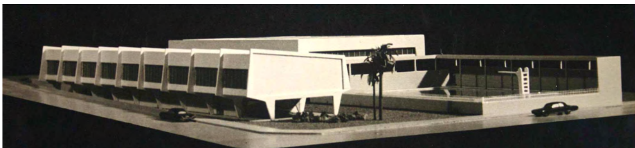
Figuras 14, 15 e 16: Maquete concebida na década de 50 de acordo com o ante-projeto, Escola Sesc-Senac de Ribeirão Preto, autoria de Oswaldo Corrêa Gonçalves. Observar os três blocos que faziam parte da concepção inicial da escola. Fonte: Foto Ferraz, arquivo FAUS
