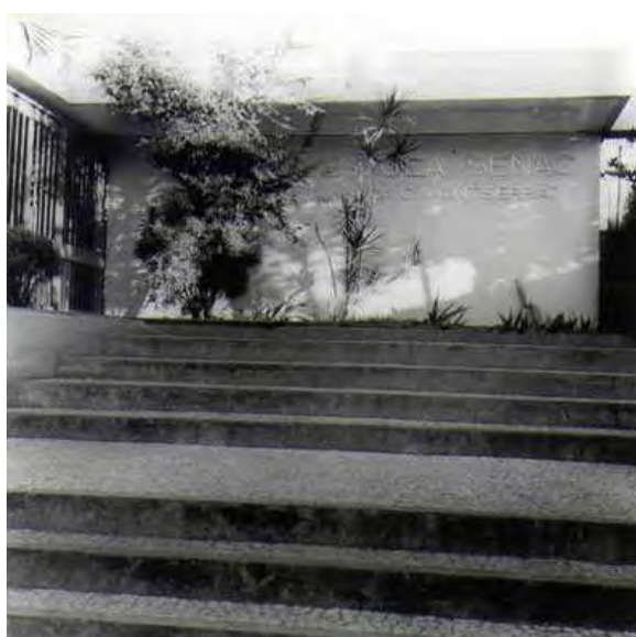
Figura 8: Observar o bloco da administração na fachada da Escola Senac de Botucatu. Escadaria de acesso e esplanada marcando o acesso principal. Fonte: Arquivo SENAC-SP
