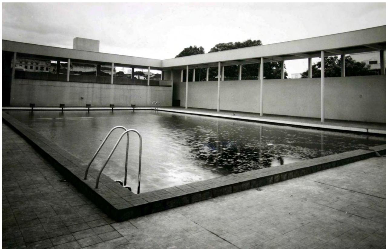
Figura 35: Segundo bloco: piscina, vestiário e terraço. Fonte: Foto Moscardi, arquivo FAUS
