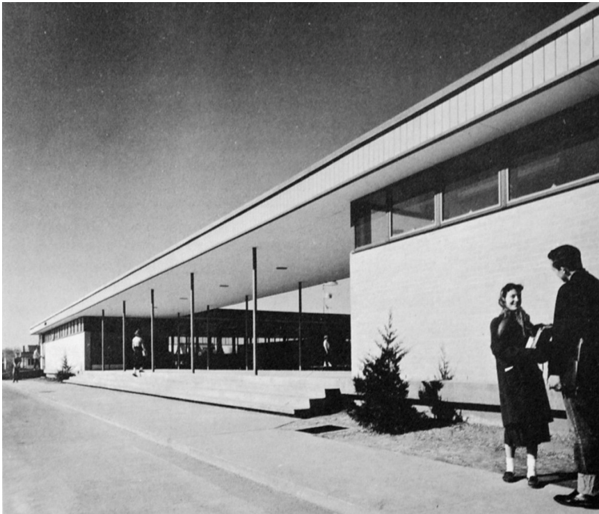
Figura 23: A linguagem do edifício-escola, de linhas retas e sem o tradicional caráter monumental, buscava ser atrativa como um centro social para os jovens de segundo grau. Fonte: Architectural Record (1956:60-61)
